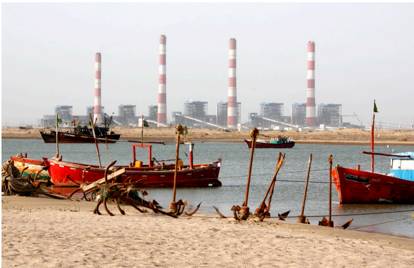
Le Megaprojet de Centrale a affecté les vies des communautés locales de pêcheurs. Photo: Joe Athialy
